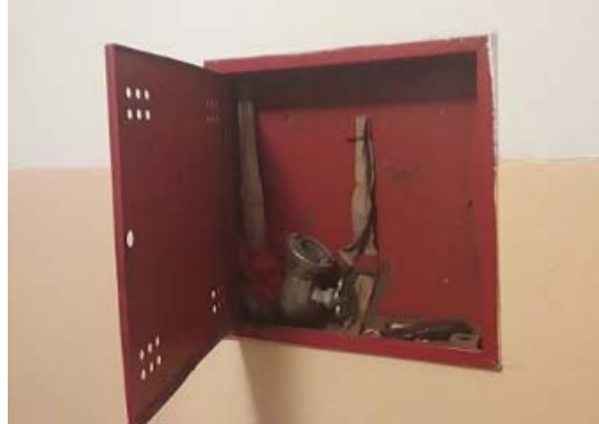
Уништен и нефункционален хидрант
