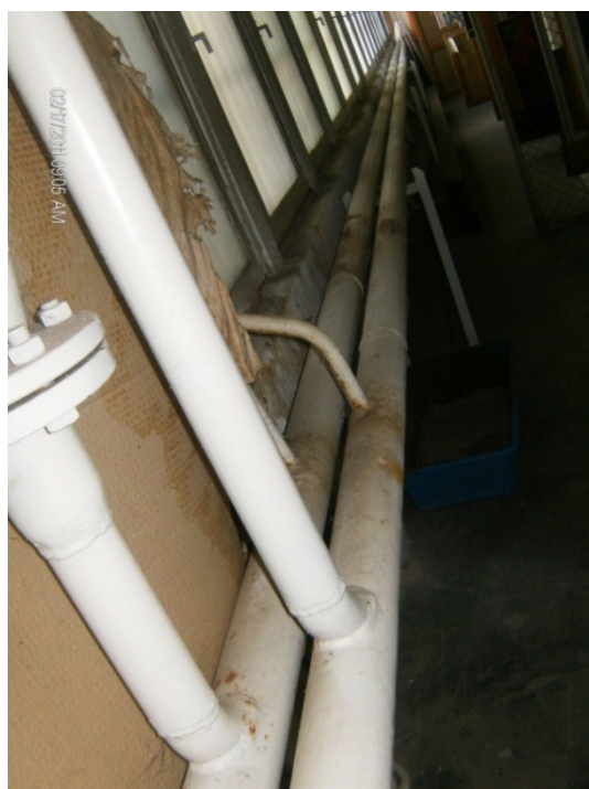
Водоводни, канализациски и цевки од парно затоплување
